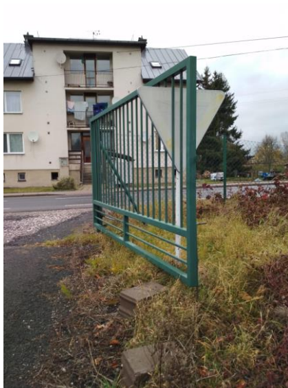
Obr. 7 Konkrétní příklad značky v havarijním stavu
